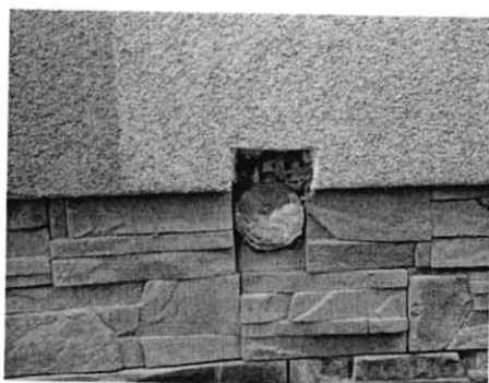
Obr. 3 Príklady vynechania výrezu: Geodetický bod môže ostať na fasáde priznaný alebo zakrytý plastovou chráničkou, prípadne kovovou mriežkou
