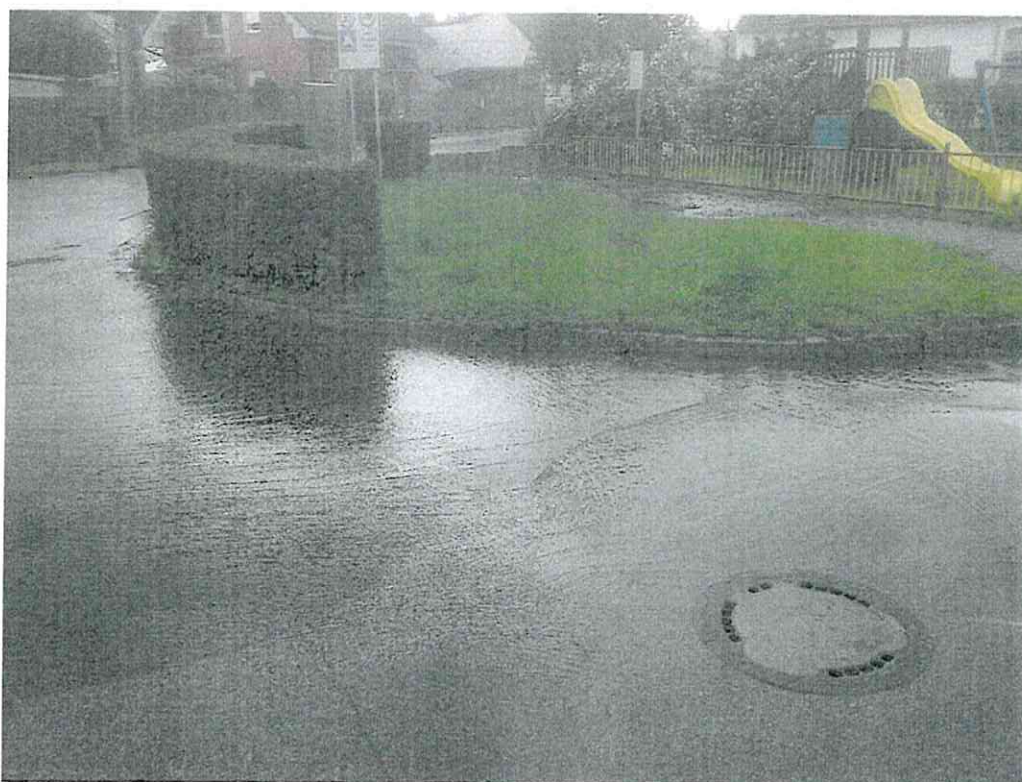
Dažďová voda z Dubovského ulice vtekajúca do splaškovej kanalizácie (jún 2016), rovnaký stav je pri každom intenzívnejšom daždi.
