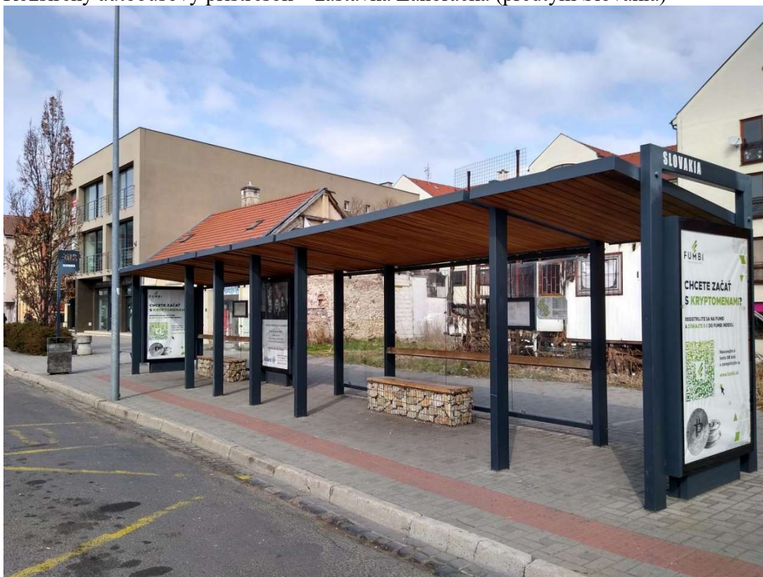
Rozšírený autobusový prístrešok – zastávka Záhorácka (predtým Slovakia)
