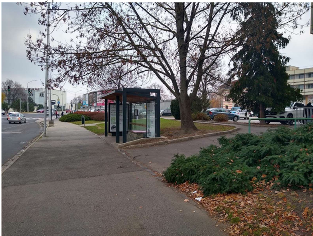
Autobusový prístrešok – zastávka Sasinkova
