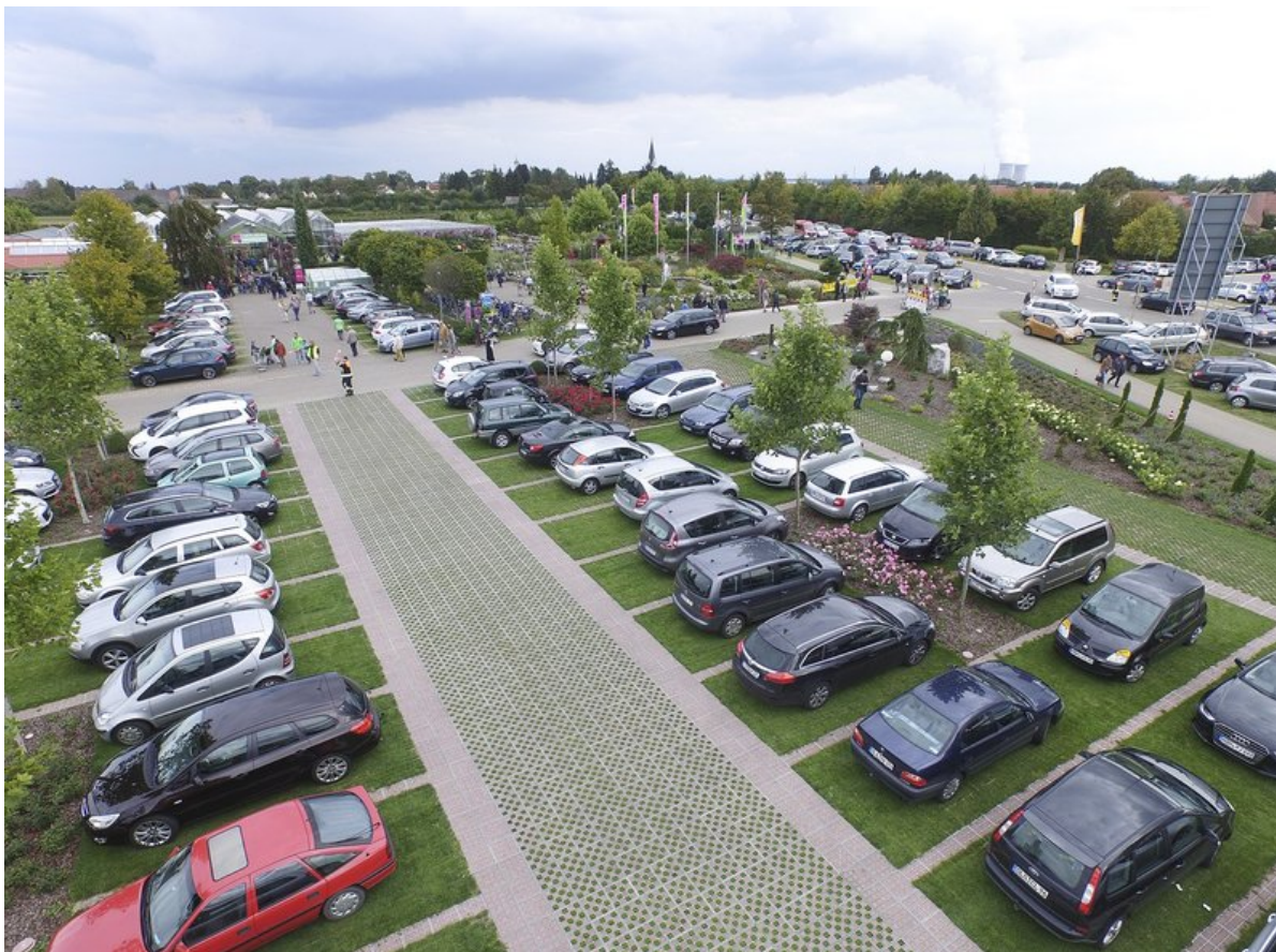
Ilustračný obrázok parkoviska realizovaného prostredníctvom ekologických vsakovacích roštov
