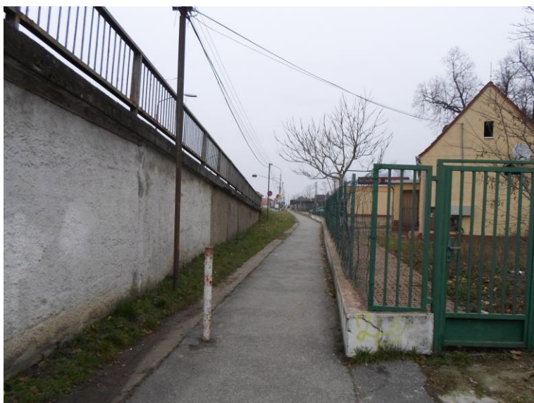
Foto č. 45: Legionárska ulica – doplnková trasa bude vedená po jestvujúcom povrchu chodníka pre chodcov s tým, že bude rozšírený na dostupné maximum (aspoň 2 m, vo výnimočnom prípade 1,75 m) + bezpečnostné odstupy podľa TP 07/2014. Chodník sa preklasifikuje na spoločnú cestičku pre chodcov a cyklistov.
