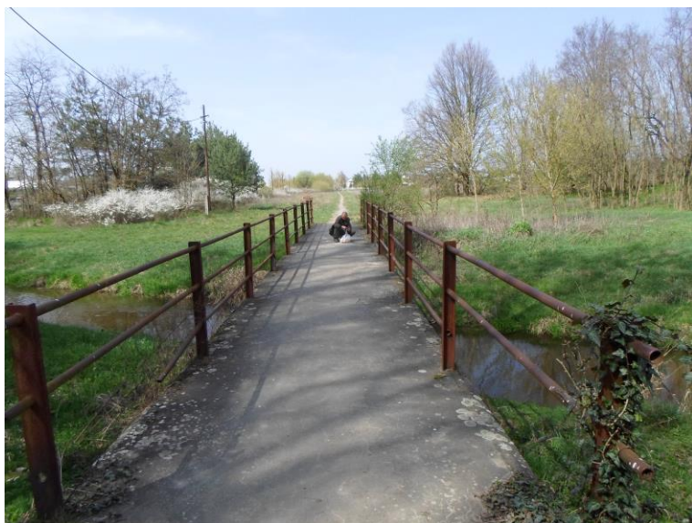
Foto č. 46: Ota Kožucha – križovanie s riekou Malina. Jestvujúce teleso mosta odporúčame rozšíriť, opraviť povrch a zvýšiť zábradlie aspoň na 1,3 m.
