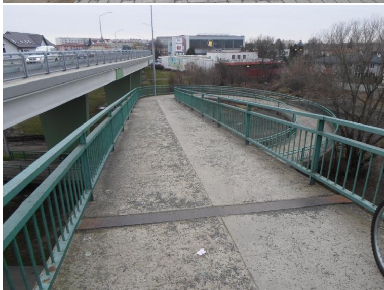
Foto č. 17: Slimák – na nadchode pre chodcov a cyklistov je nevyhnutné zvýšiť jestvujúce zábradlie, aby sa zabránilo prepadnutiu cyklistov na žel. trať. Tiež je nevyhnutná výmena povrchu nadchodu.
